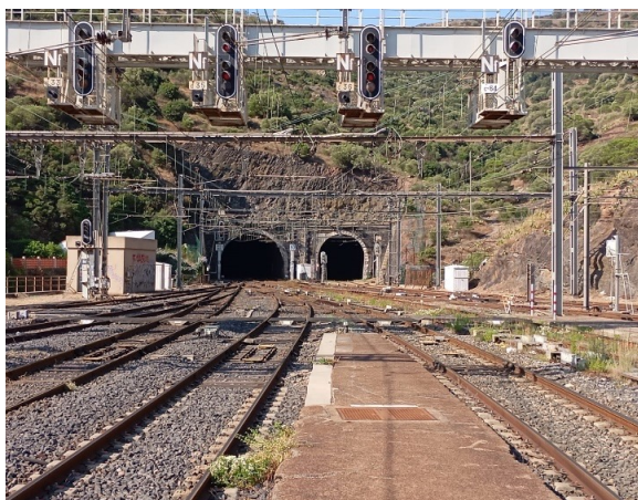
Imatge 22. Túnel ferroviari que connecta amb l'Estat espanyol. Font: CCAR (2025)
